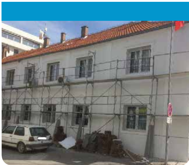
Slika 2: Objekat opštine Vitina tokom renoviranja
