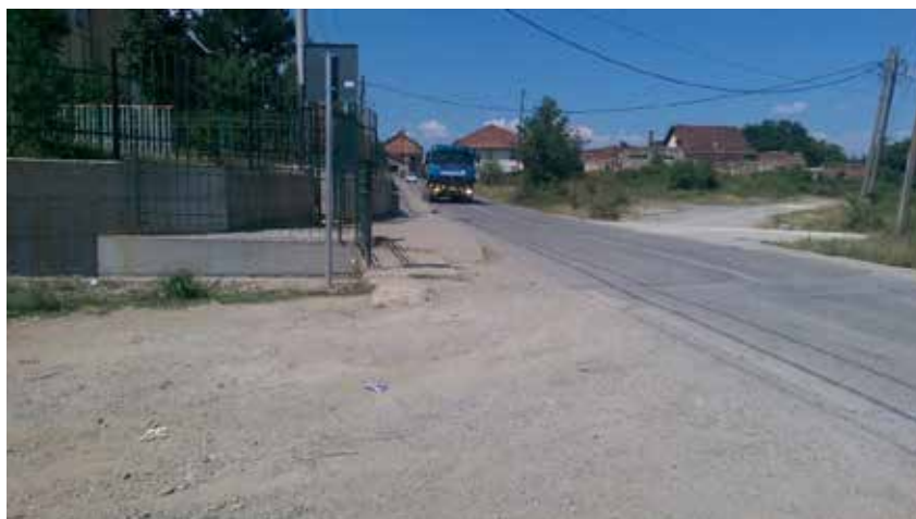
Sl. 5. Nedostatak signalizacije
