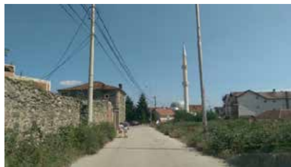
Sl. 12. Nedostatak signalizacije
