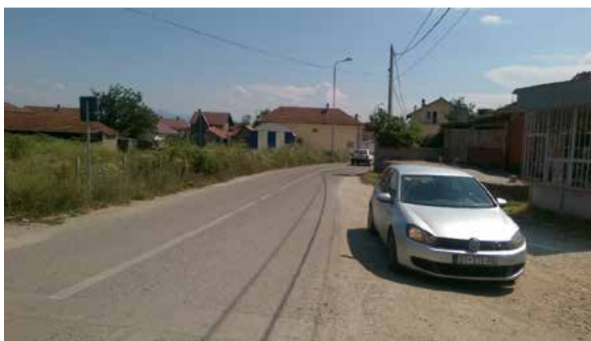
Sl. 6. Nedostatak signalizacije
